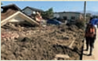
▲濁流に家屋を飲み込まれた被災現場
